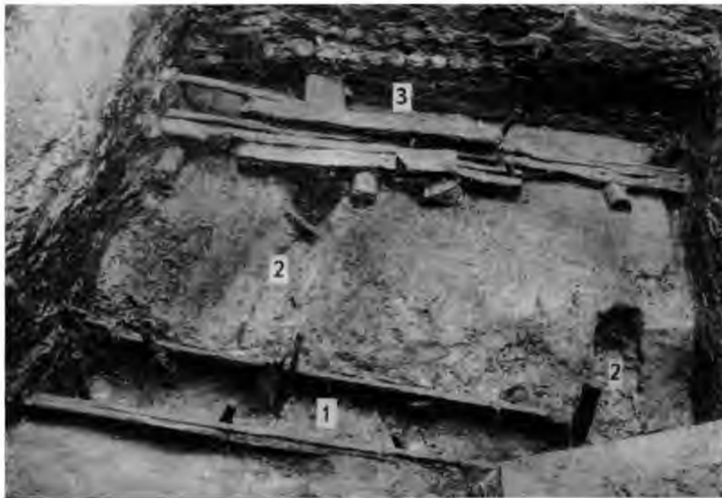
20. att. L. Pils ielas izrakumos atsegta 13. gs. drenāžas sistēma. 1 — kolektorgrāvis, 2 — notekudeņu pievadgrāvīši, 3 — ēkas pamati.
