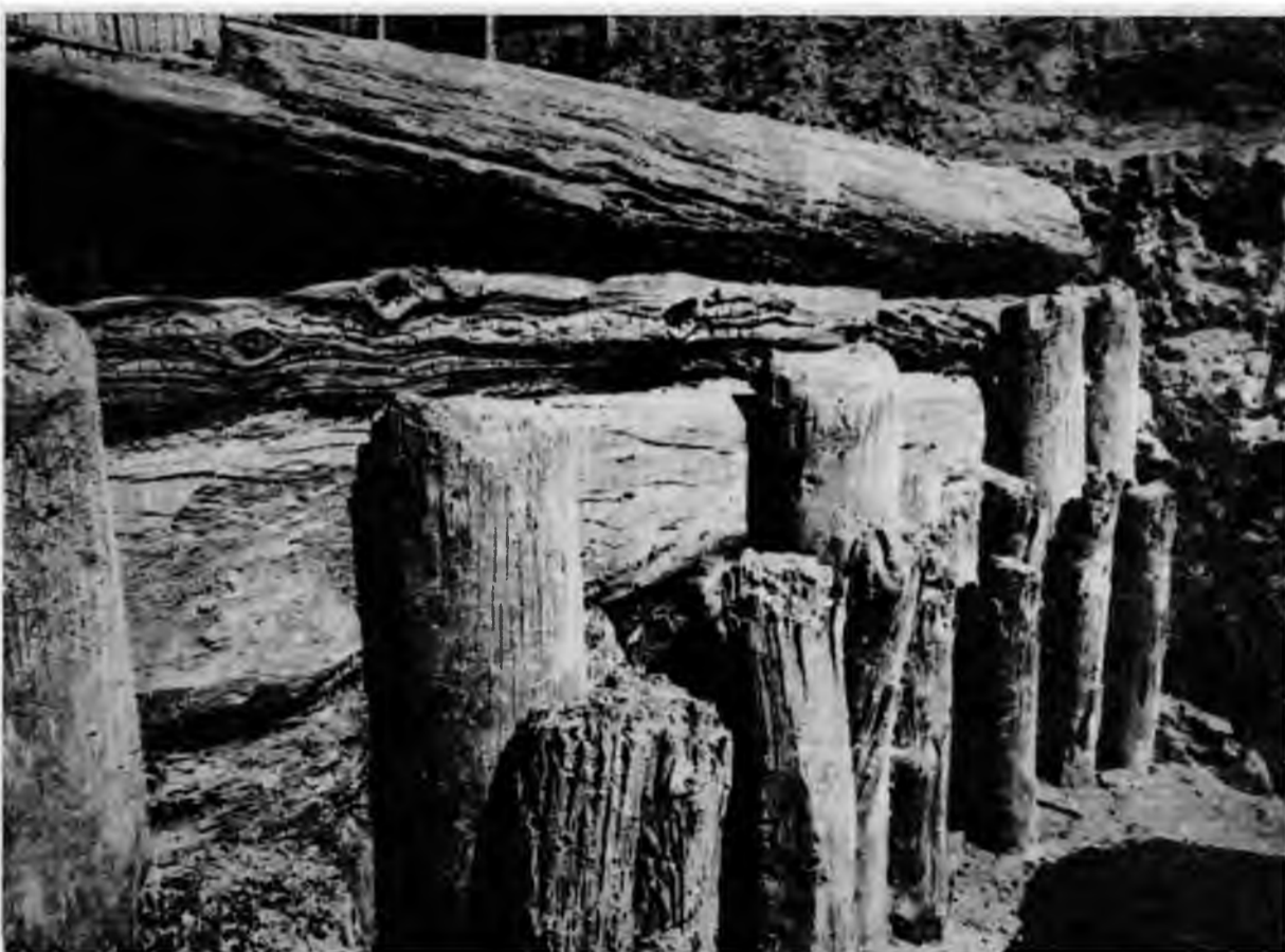
5. att. 13. Janvāra iela atsegtie 15.—17. gs. Rīgas upes krasta nostiprinājumi.
