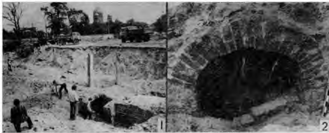
38. att. Komunaru ielā atrastā apakšzemes eja. 1 — ejas atrakšana buvbedre, 2 — ar ķieģeļiem aizkrautais ejas gals.
